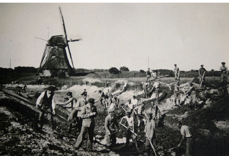
Grabenausbau von Hand in den dreißiger Jahren
