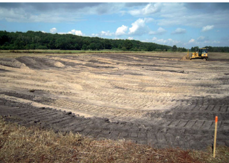
Abb.3: Abschieben des humosen Oberbodens bis auf den nährstoffarmen Sand mit einer Planierraupe Foto: Rickert
