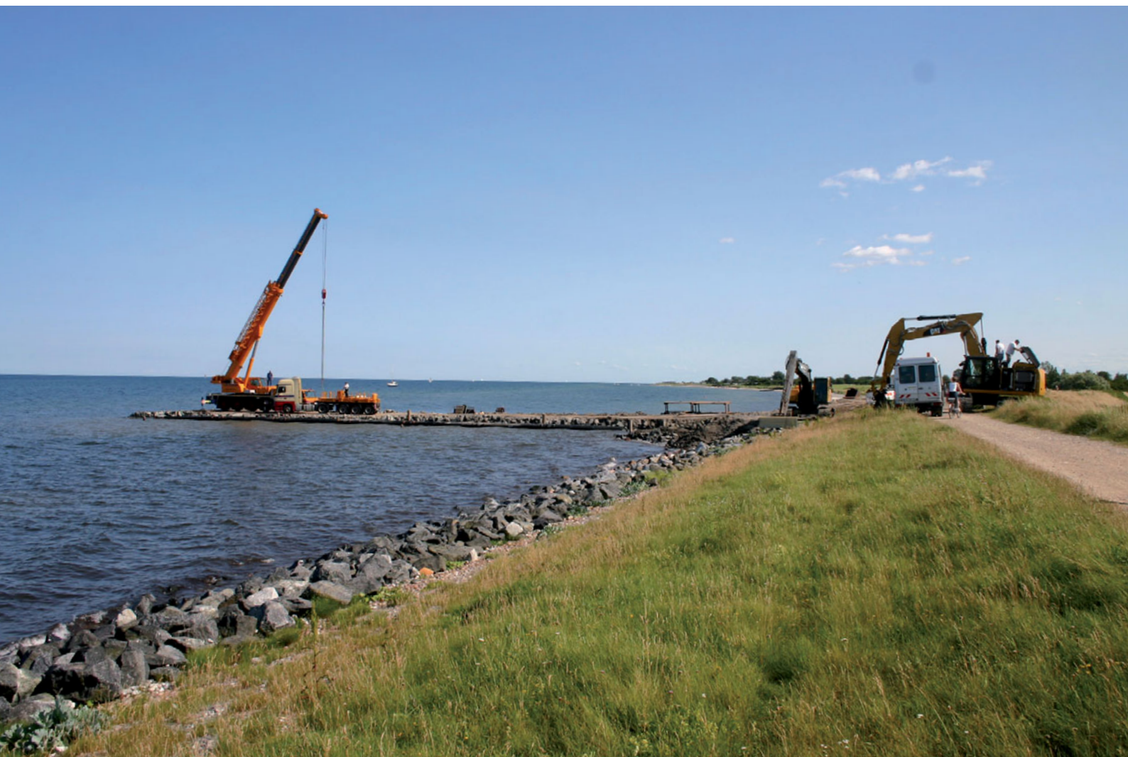
Abb.1: Bau des Einstromwerks Foto: Nils Kobarg
